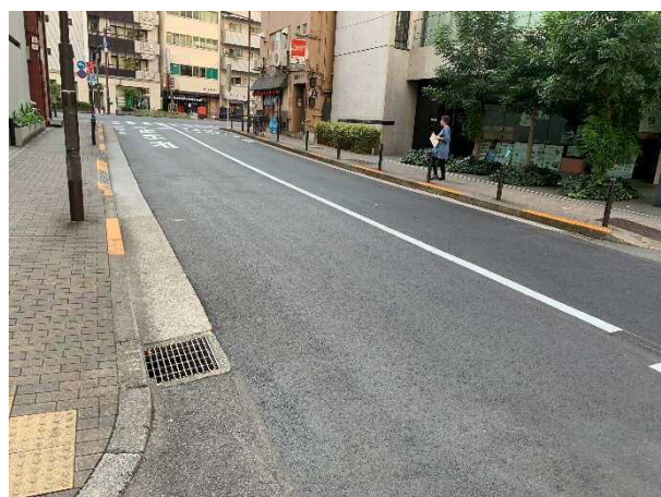
処置後の状況
