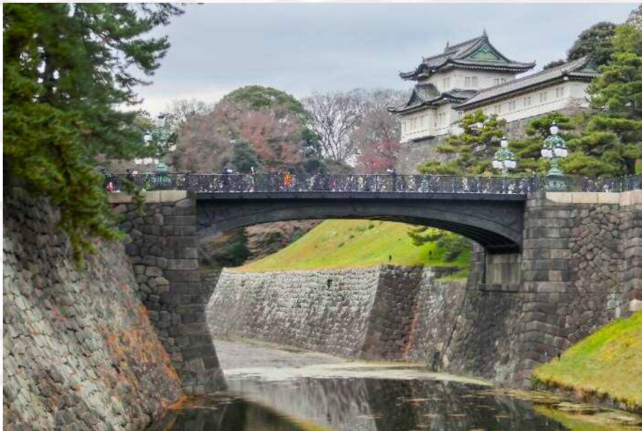
◆写真9 現在の皇居正門鉄橋
