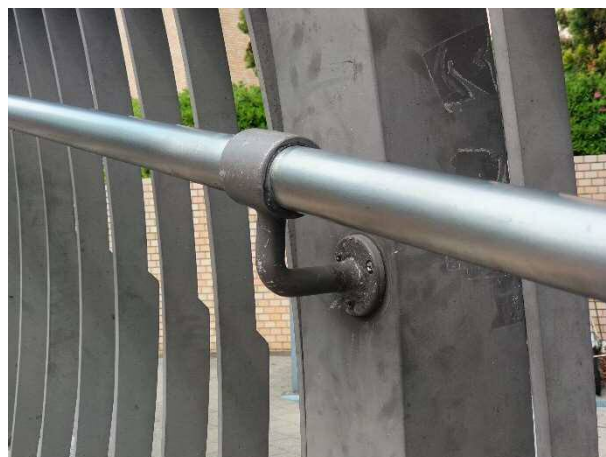
処置後の状況
