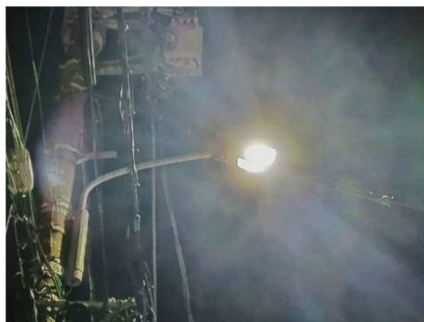
処置後の状況
