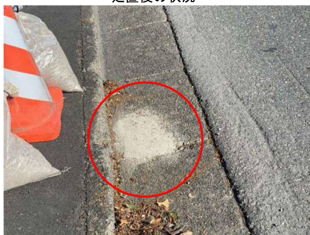
処置後の状況
