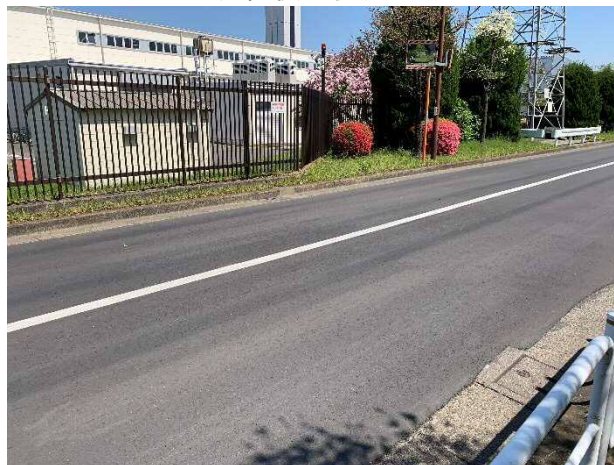
処置後の状況
