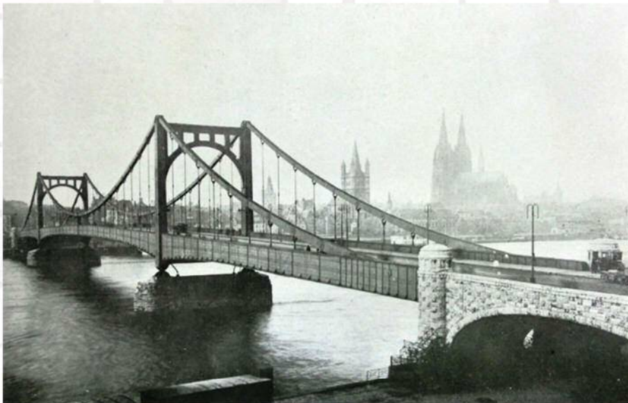
◆清洲橋のモデルになったケルン吊橋
