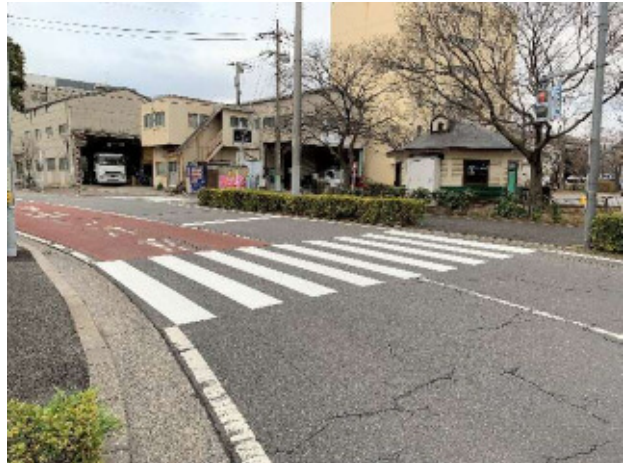
処置後の状況
