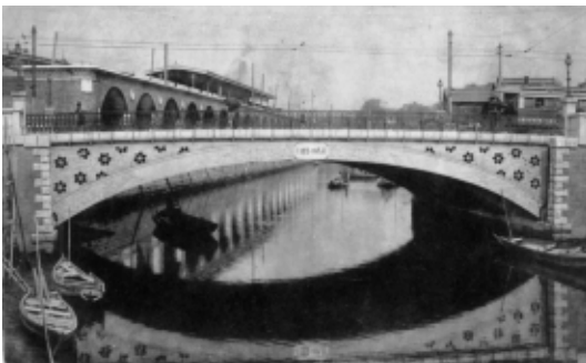
◆1903 年（明治 36 年）に架け替えられた鋼鉄製のアーチ橋
