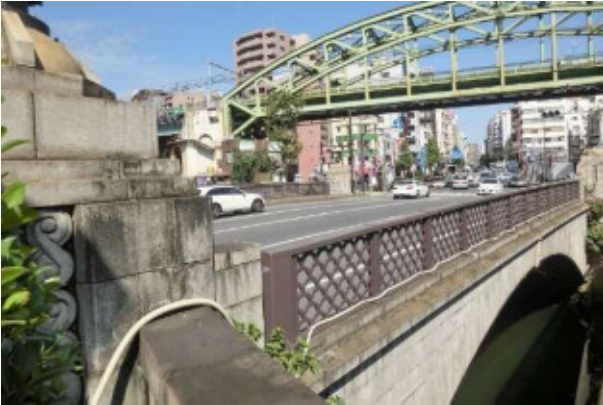
◆昌平橋（車道橋）
