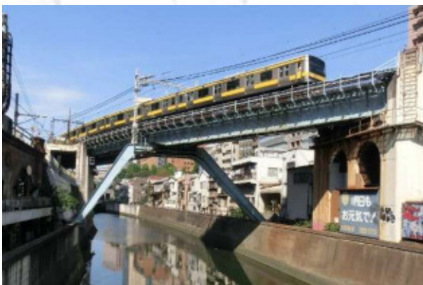
◆総武線神田川橋梁
