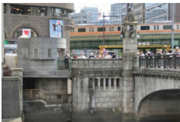
◆万世橋地下室（元公衆便所）
