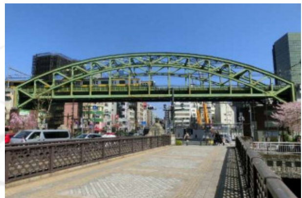
◆松住橋架道橋
