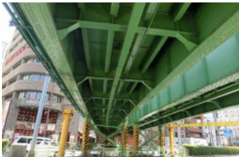
◆万世橋架道橋（日本初の曲線橋）
