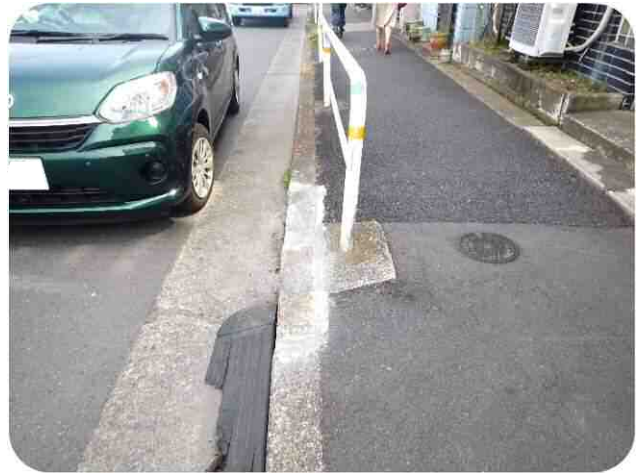
処置後の状況
