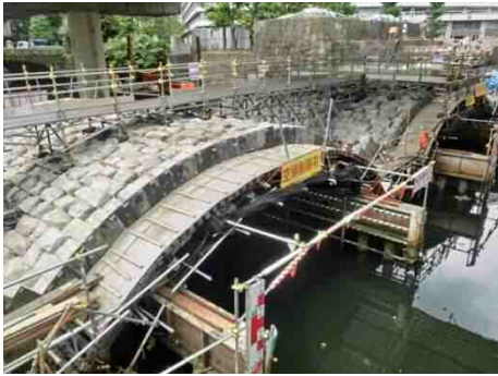
常盤橋解体状況
