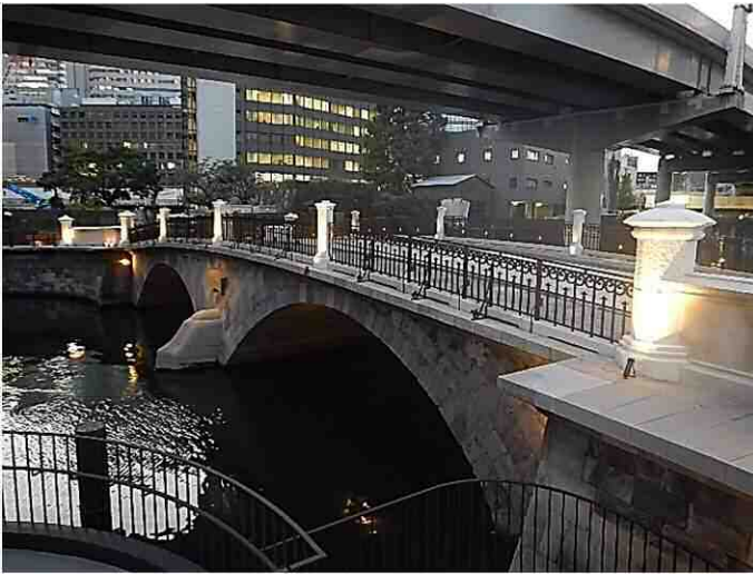
修復が終わった常磐橋
