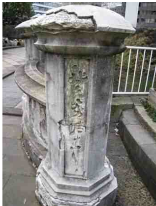
工事以前の西洋風デザインの親柱 (表面のモルタルは、震災復興時の工事で補修されたもの)
