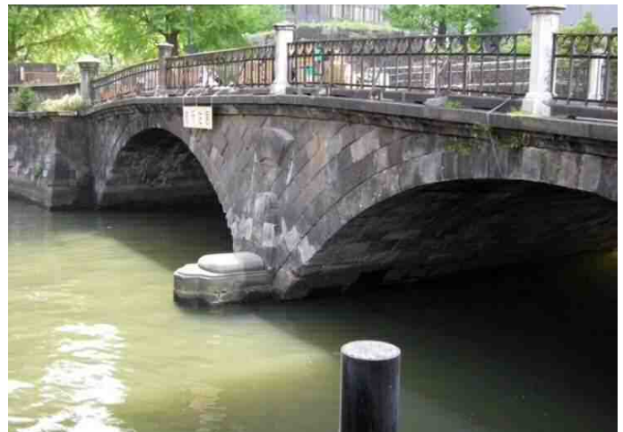
解体工事前の常磐橋（橋脚下部に設けられた、水切りは震災復興で改造されたもの。今回の工事で、オリジナルのものへ取り換えられた。）
