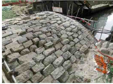
アーチ石はさほど整形されていない 石で組まれていた
