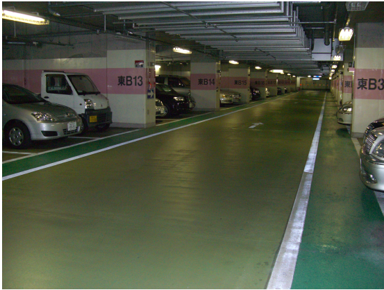
図 3-19 B 駐車場内部
