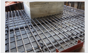
大井南陸橋(下部工事) ▲
