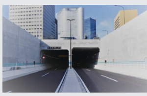
環状二号線築地虎ノ門トンネル ▲
